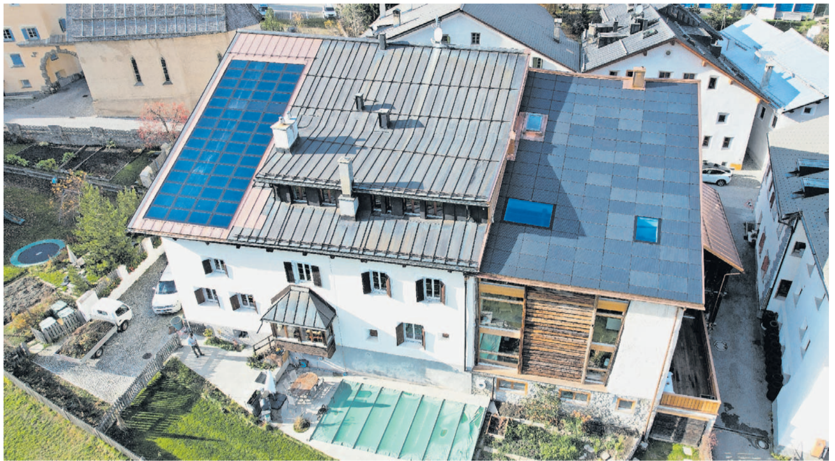
Vista our da l'ajer sül stabilimaint a Zuoz cul talvo ed il nouv implaunt fotovoltaic a dretta e l'implaunt solar gia existant a schnestra. Il rest da l'energia bsognaiva per s-chuder las abitaziuns deriva da l'implaunt da s-chudamaint a distanza. fotografias: mad
